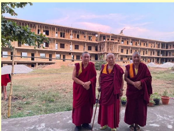
Geshela tijdens de bouw met Tsawa management
